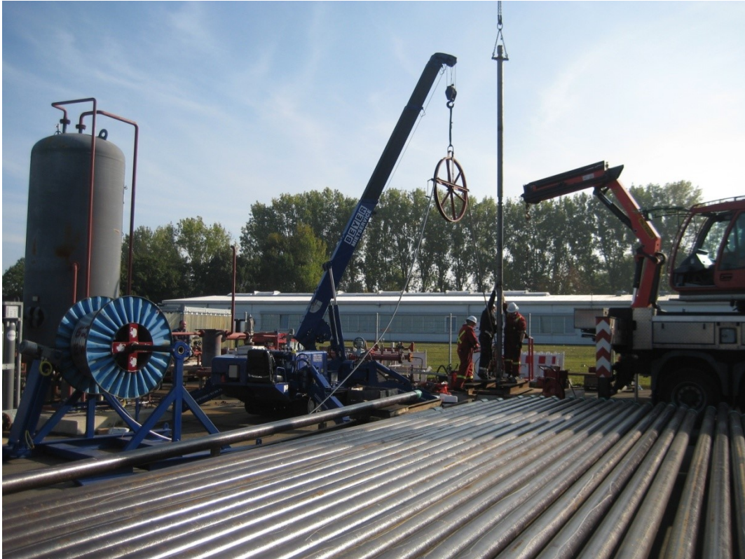
Abb. A-6: Einbau einer Förderpumpe im Geothermieprojekt Bruchsal. Zu sehen sind die Steigleitung (Vordergrund unten) und die Electrical Submersible Pump hängend am Kran (Hintergrund). Ebenfalls zu sehen ist der Druckausgleichsbehälter des Thermalwassersystems (links). (EnBW, 2012)
