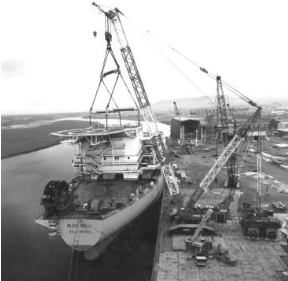
Abbildung 1.1: Einsatz eines Gittermast-Fahrzeugkrans
