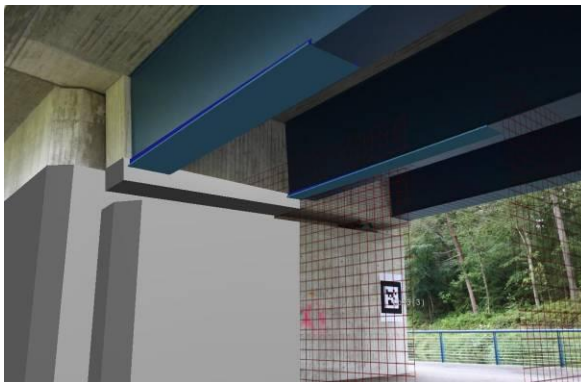
Abbildung 5.1-1 Baufortschrittskontrolle mit Hilfe von Augmented Reality
