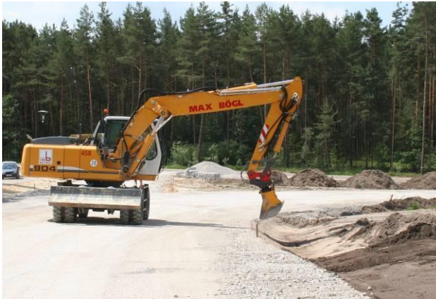
Abbildung 3.4-23: GNSS-gesteuerter Bagger bei Grabenmodellierung
