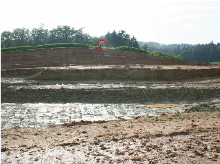
Abbildung 3.2-23: Terrestrischer Laserscanner (Leica Scanstation, oben in Bildmitte) bei der Aufnahme eines Einschnittsbereichs vom Kronenrand aus
