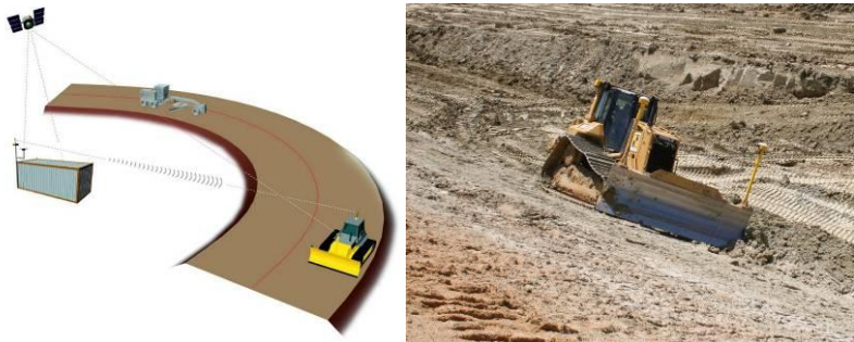
Abbildung 3.4-22: GNSS-Steuerung (Prinzip und realer Einsatz, hier: 2-Mast-System an Raupe bei Böschungsmodellierung)
