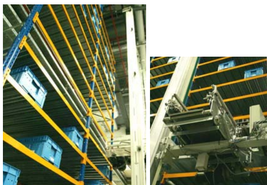
Abb. 8-2: Automatisches Kleinteilelager mit Regalbediengerät in Zwei-Mast-Version
