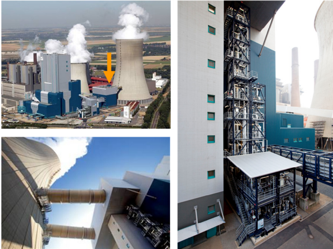
Abbildung 3.1: Standort der CO 2 -Wäsche am Block BoA1 des Kraftwerks in Niederaußem (gelber Pfeil) (links oben: Block BoA1; links unten: CO 2 -Wäsche zwischen dem Gebäude der Rauchgasentschwefelungsanlage und Kühlturm; rechts: CO 2 -Wäsche)
