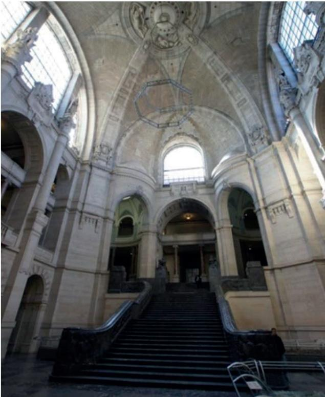
Abb. 3: In der monumentalen Zentralhalle des Neuen Rathauses in Hannover (erbaut 1901-1913) wurden Savonnières- und Morley-Oolithe parallel verwendet, wobei Morley-Oolith für die statisch tragenden Teile eingesetzt wurde.
