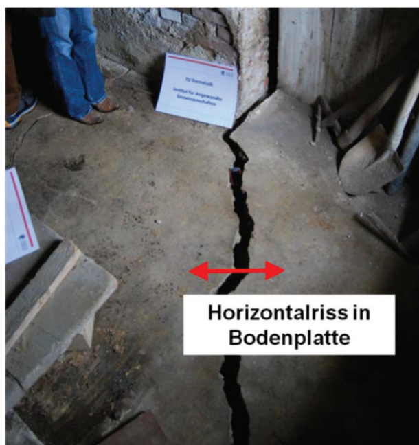
Abb. 10: Horizontalriss in einer Bodenplatte aus Beton.
