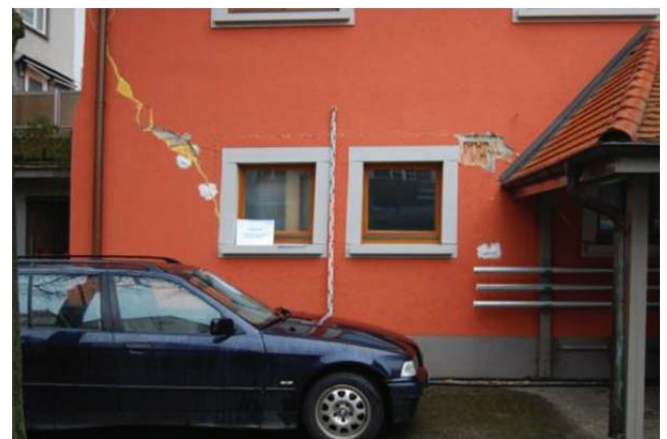
Abb. 7: Risse am Bauamt der Stadt Staufen
