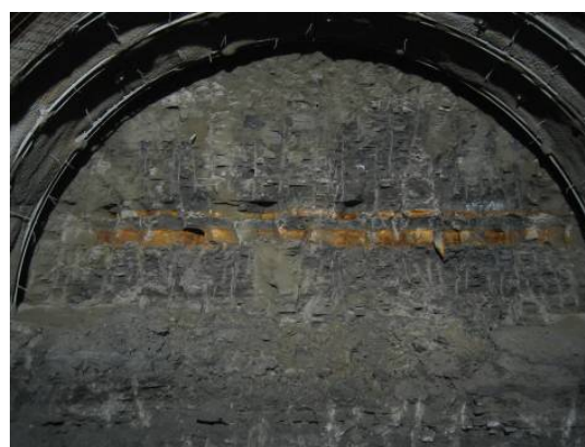
Abb. 4.19 a bis c: Abschlag 2, 3. Folgemessung: Ortsbrustverformungen nach ca. 5 h 20 min.
