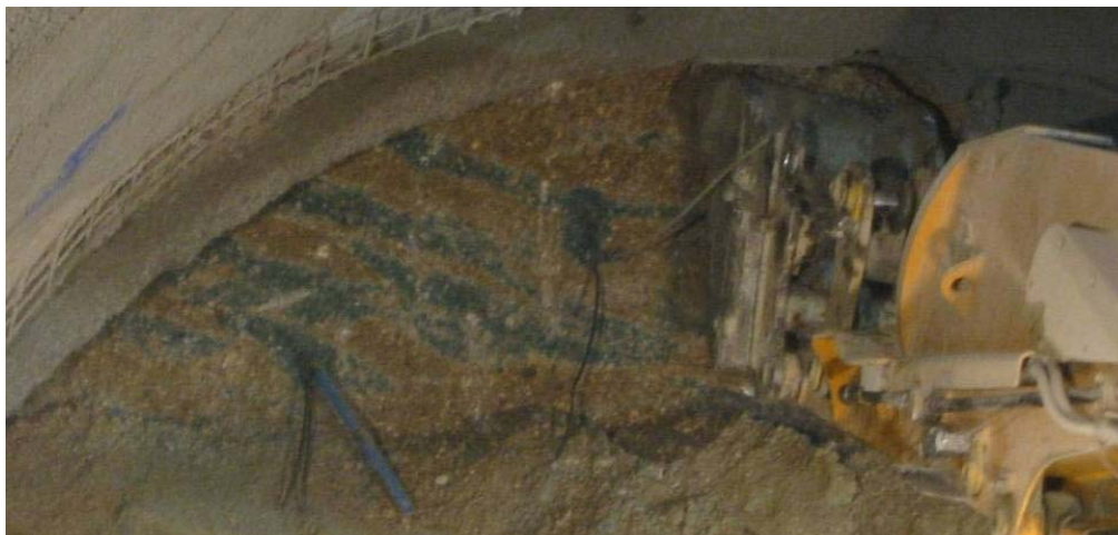
Abb. 9.28: Horizontale Ausbreitung des Injektionsguts in sand- und feinkornarmen Kieslagen
