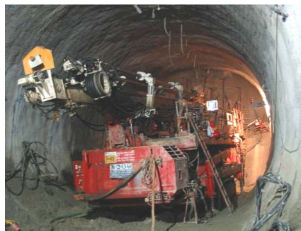
Abb. 9.24: Injektion von der Ortsbrust
