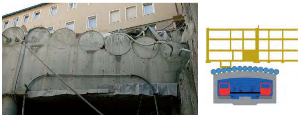
Abb. 9.54: Beispiel eines Rohrschirms mit großem Rohrdurchmesser (Fürth, 2004)
