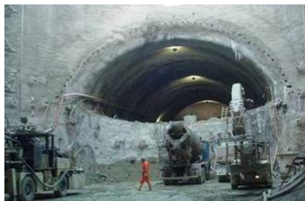
Abb. 9.33: Kalottenvortrieb
