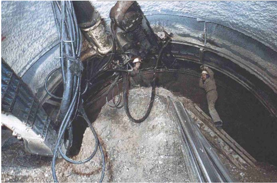
Abb. 2.5 a u. b: Kalottenvortrieb im Kies mit Stützkern und Pfändung im Firstbereich (LH München, 1990)
