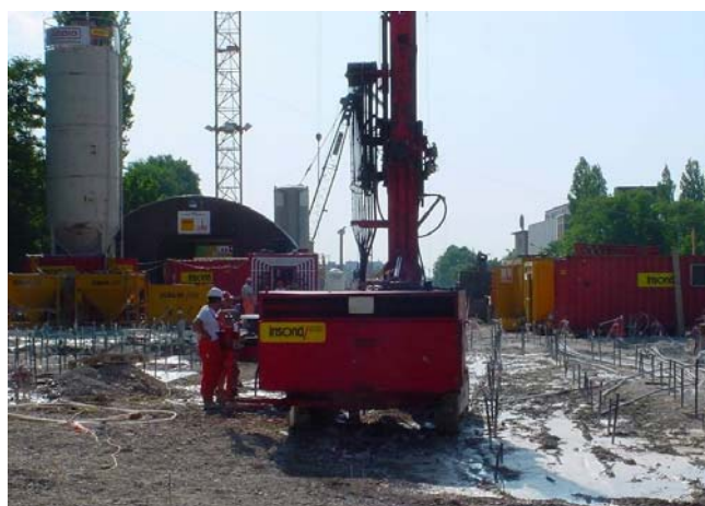
Abb. 9.23: Manschettenrohrinjektion von GOK
