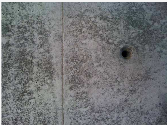
Abbildung 6: Fleckige Dunkelverfärbungen mit bislang ungeklärter Ursache an Bauwerken in München (links oben), Düsseldorf (links unten) und Buenos Aires (rechts)
