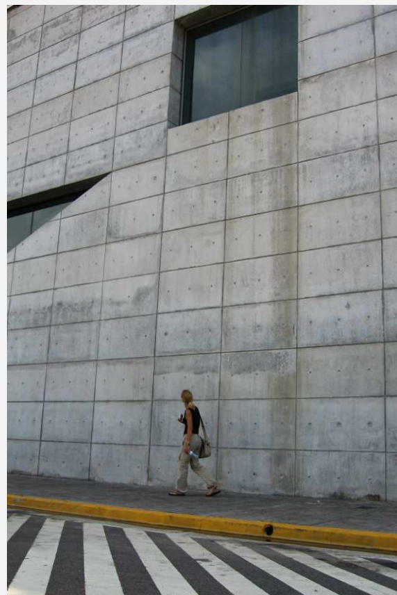
Abbildung 6: Fleckige Dunkelverfärbungen mit bislang ungeklärter Ursache an Bauwerken in München (links oben), Düsseldorf (links unten) und Buenos Aires (rechts)
