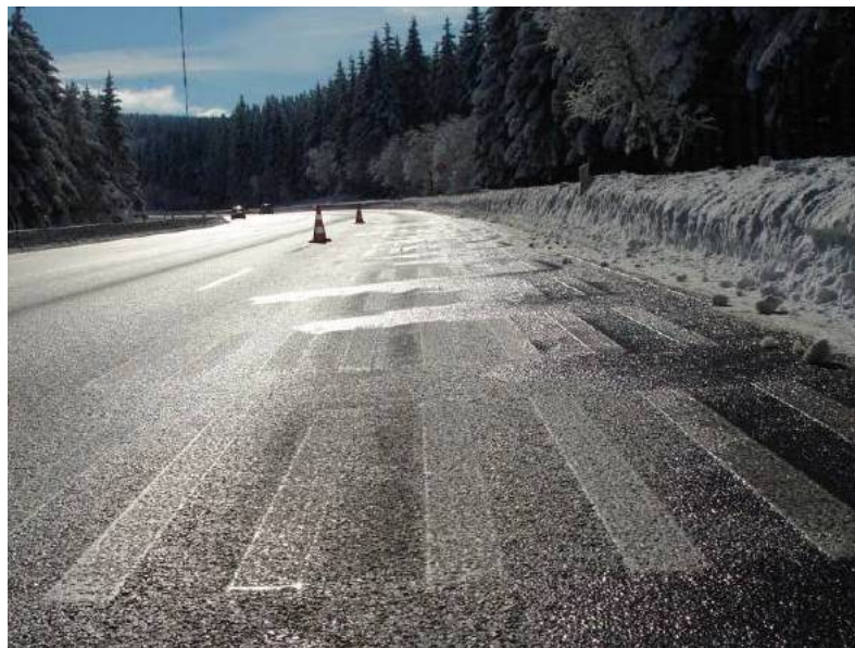
Abbildung 3.8: Aufnahme einer Typ II Agglomerat-Markierung bei Gegenlicht [Die07]. Ein großer Nachteil von Typ II Markierungen ist ihre schlechte Tagsichtbarkeit bei Gegenlicht, die eine Erkennung mit einem videobasierten System erheblich erschwert.
