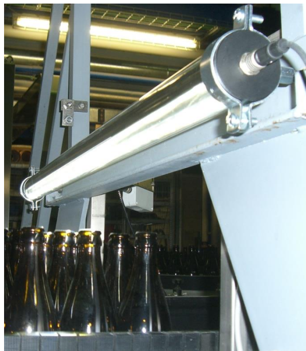
Abbildung 37: LED-Leiste als Beleuchtungsquelle für den Sensor
