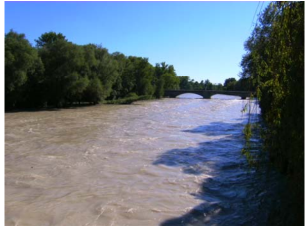
Abbildung 1: Hochwasser der Isar im August 2010 (Quelle: eigene Fotografie)
